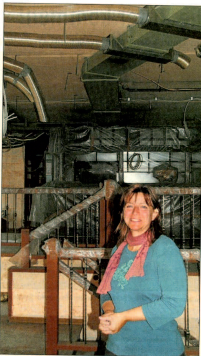
Rieckhof-Mitarbeiterin Ulrike Niß verfolgt die Bauarbeiten im Gastronomie-Bereich. Foto: sl
