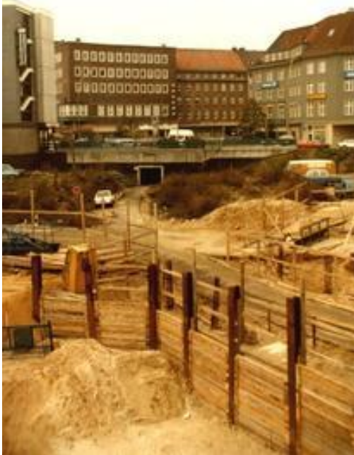
November 1982: Bauarbeiten an der Seevepassage beim „Gloriatunnel“. Foto: Hansen
