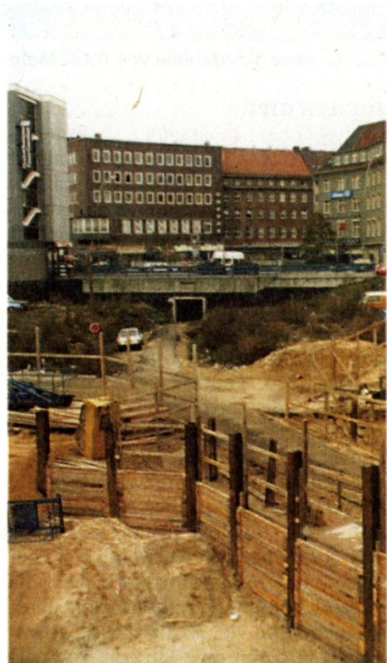
Blick vom Rieckhof auf die Baustelle Gloriatunnel im November 1982
