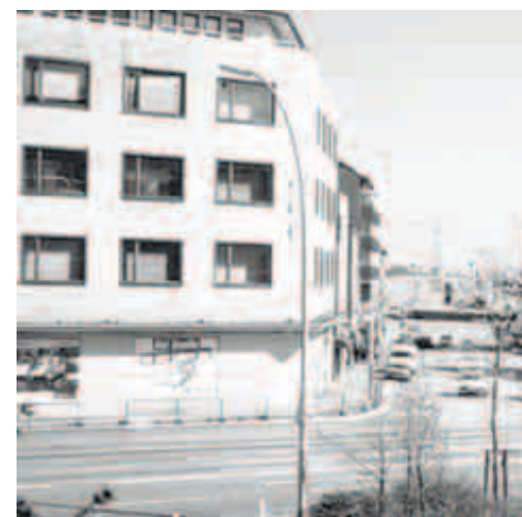
Blick in die Moorstraße Ende der 70er-Jahre penburg-Haus. Hinter dem Gebäude rechts
