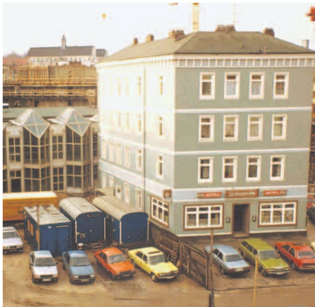
Bauwagen stehen 1984 vor dem fast fertigen Rieckhof. Rechts ist das Gebäude mit der Kneipe „Stumpfe Ecke“ zu sehen. Im Hintergrund: die Baustelle der Wohnungen an der Seevepassage.
