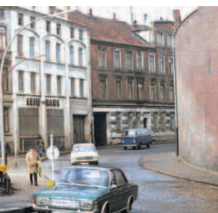
Die Ecke Krummholzberg in Richtung Seeve, steht jetzt das Harburg Carree.
