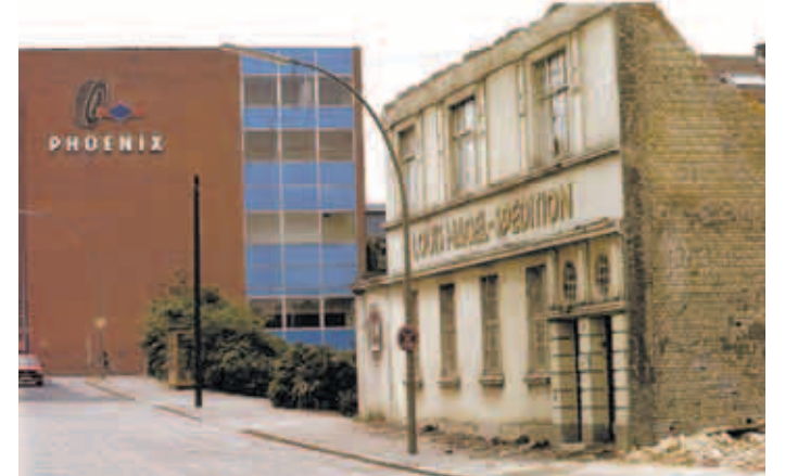
An dieser Stelle der damaligen Gruppenstraße steht heute das Marktkauf-Center. Die Aufnahme stammt aus den 70er-Jahren.
