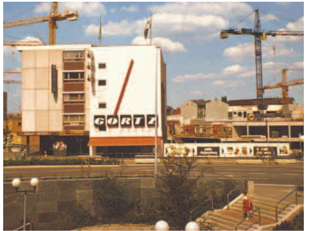
Im September 1982: Unzählige Baukräne prägten damals das Bild im Seeveiertel. In der Mitte steht noch das Harburger Görtz-Haus, das kurze Zeit später abgerissen wurde.
