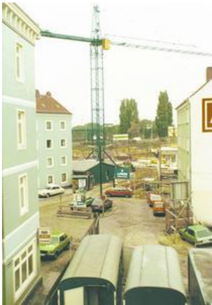
SeeveViertel, Ende 1982: Die Baustelle Suba-Center. Foto: Jörn Hansen
